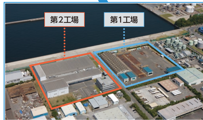
袖ヶ浦第1工場・第2工場 (敷地面積合計12,000坪) 袖ヶ浦第2工場 (第1工場と同規模) が今年度中に大手メーカーのポンプ整備工場として稼働予定
